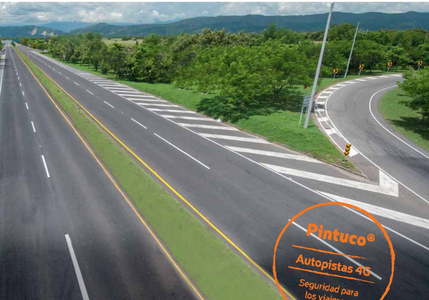
Colombia. Pintuco® suministra pinturas reflectivas y antideslizantes para las autopistas 4G. Vía Girardot - Ibagué - Cajamarca.
